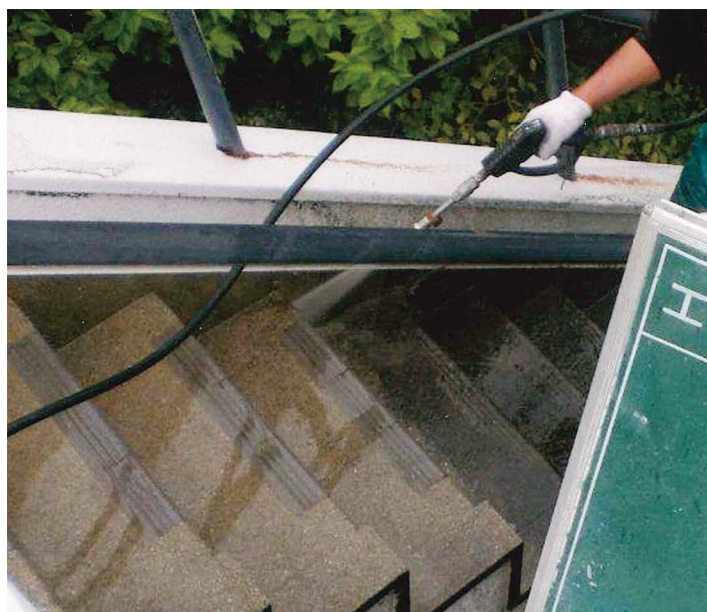
清掃後プライマー塗布
